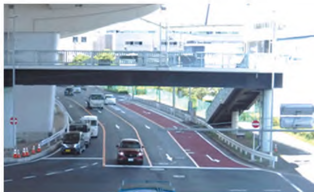
改良工事後（左折専用レーン設置）
