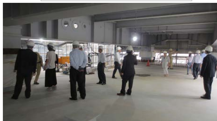
3階床下の免震層
