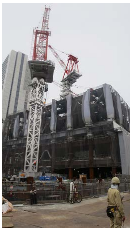
タワークレーン
