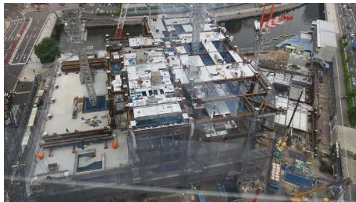
事務所フロアから見た工事現場
